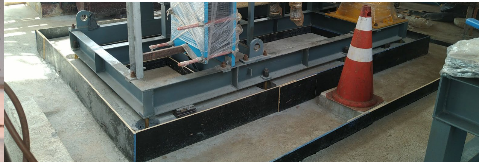
Base de equipamento feita com Emckrete EP.
