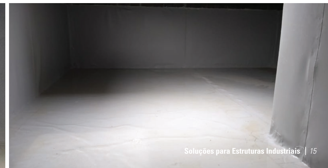
Reservatório impermeabilizado com MC-Plan 112 PW.
